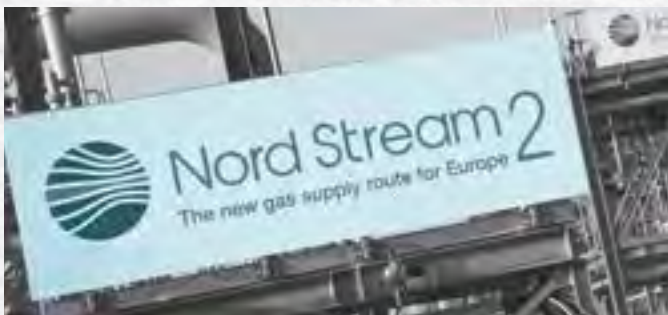
Магистральный газопровод «Северный Поток – 2» («Nord Stream 2») п. Усть-Луга, Ленинградская обл., 2019 г.
